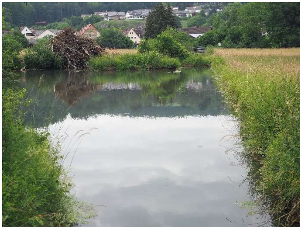
Abzweig des Treibwasserkanals (links) von der Lauter
