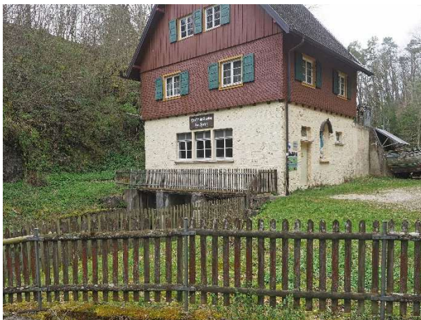
Das Kraftwerk für Untermarchtal
