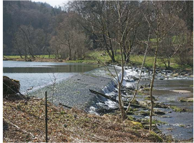
Stauwehr an der früheren Bronner Mühle
