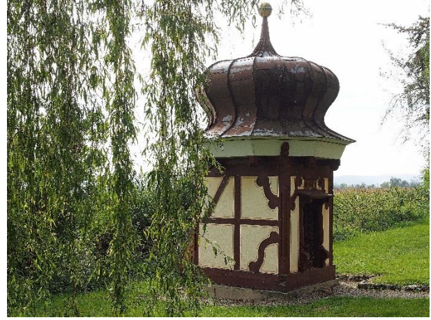
Ehemalige Quelle mit Verschluss
