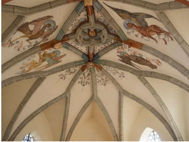
dem Kreuzrippengewölbe im Chor,
